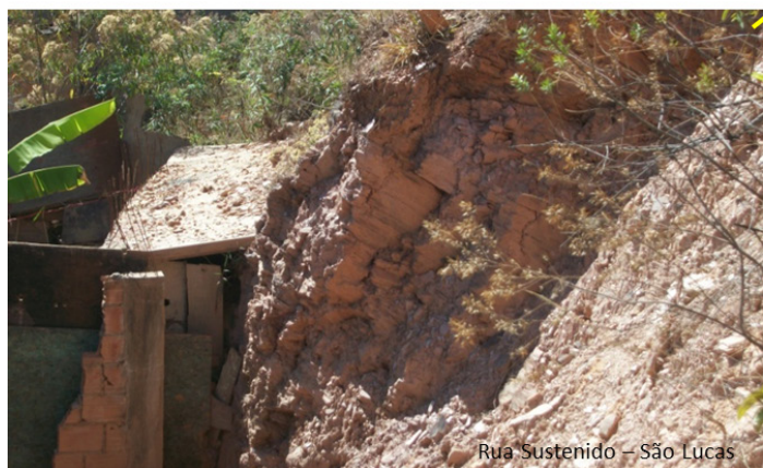
Figura 10. Tombamento e queda de blocos de filitos do Grupo Sabará sobre casa no bairro São Lucas de Belo Horizonte. A foto da esquerda exibe detalhe do processo e a foto da direita mostra a localização da casa.
