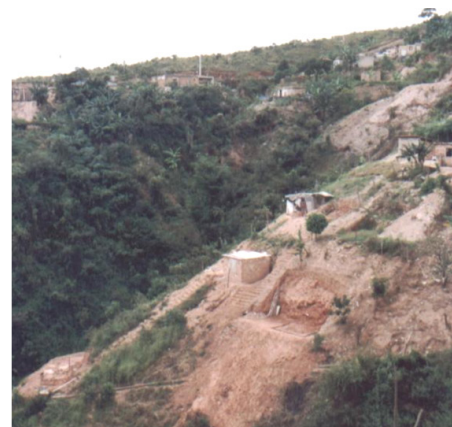
Figura 6. Condicionantes antrópicos dos escorregamentos. Lançamentos de terra descartada, cortes subverticais que desconfinam descontinuidades e contatos entre solos e o maciço rochoso e construções sobre material inconsolidado. A foto da direita foi tirada no Conjunto Taquaril em Belo Horizonte.
